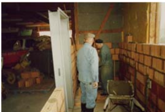
Die Toilettenanlage im Rohbau
