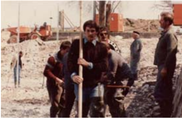
Während dem Bau
