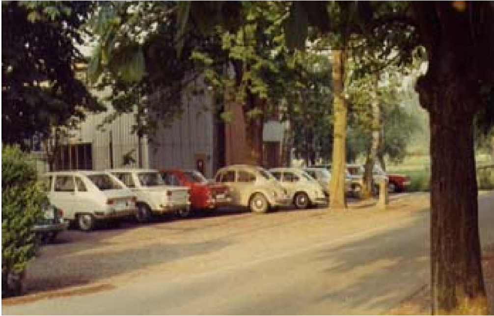
Das Bootshaus 1970 wie es sich nach dem Bau präsentierte
