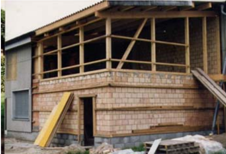
Der Motorenraum im Rohbau
