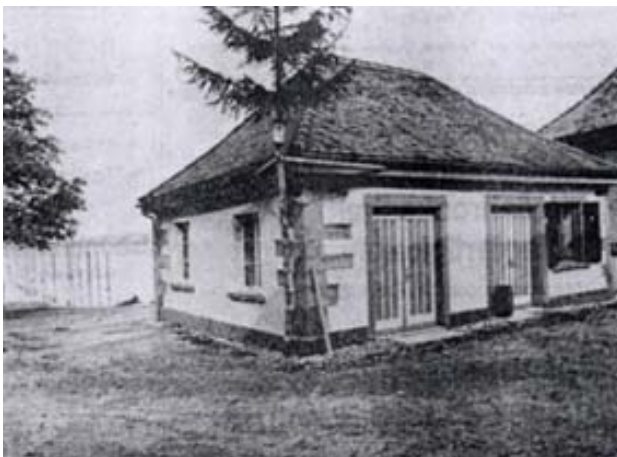
Stolz präsentiert sich das Häuschen mit dem neuen Fischputzraum
