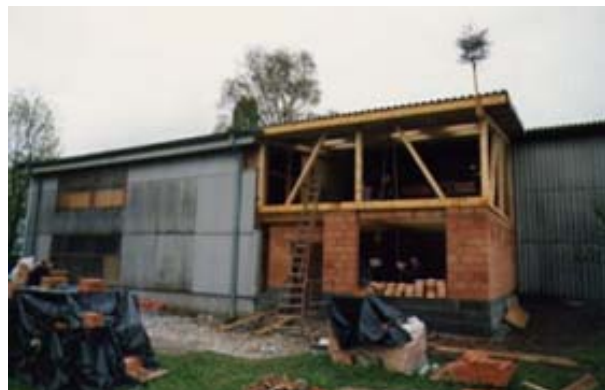
Die Fischküche im Rohbau
